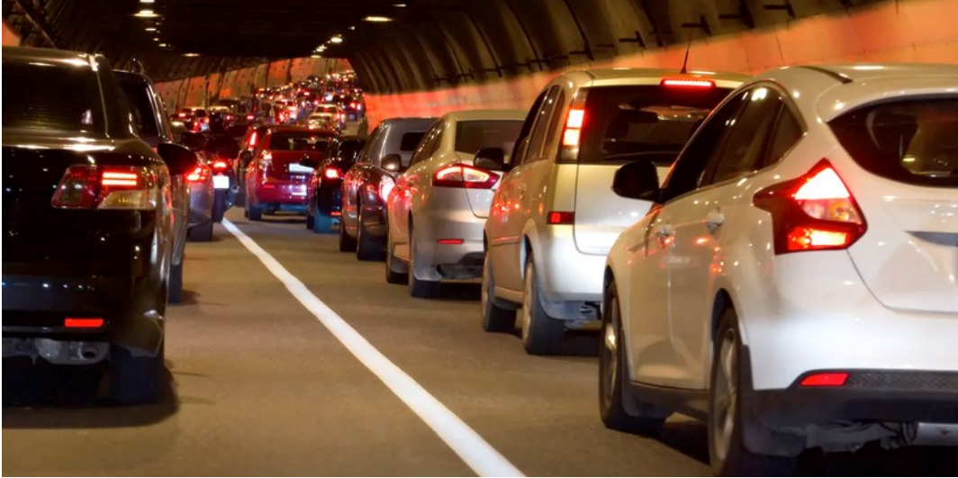
Fig. 6 Embouteillage dans un tunnel sans voie de secours – impossible pour les services d'intervention de progresser (photo : Dreamstime, https://www.dreamstime.com ).
