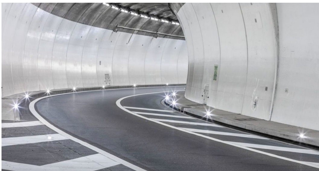
Fig. 16 Murs clairs, dispositifs de guidage optique sur l'accotement, bon éclairage (photo : Gifas, 18.12.2019, https://www.gifas.ch ).
