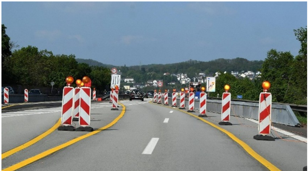
Fig. 14 Transition de voie sur un chantier autoroutier (photo : t-online, 20/07/2019, www.t-online.de ).
