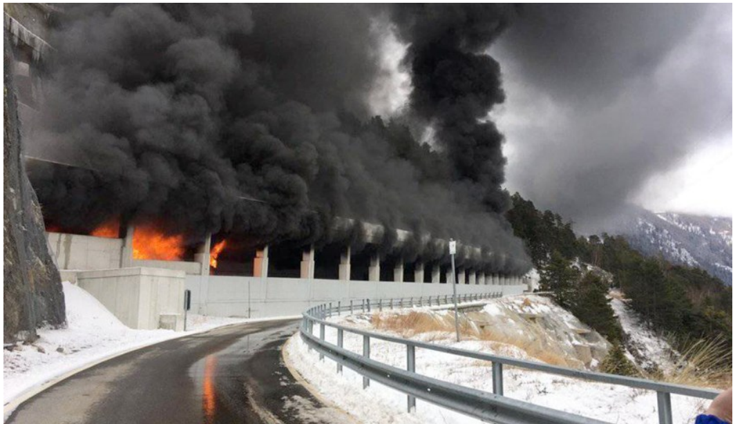
Fig. 4 Incendie dans le tunnel et la galerie du Schallberg (route du col du Simplon) (Photo : TicinoNews, 2019, https://www.ticinonews.ch ).
