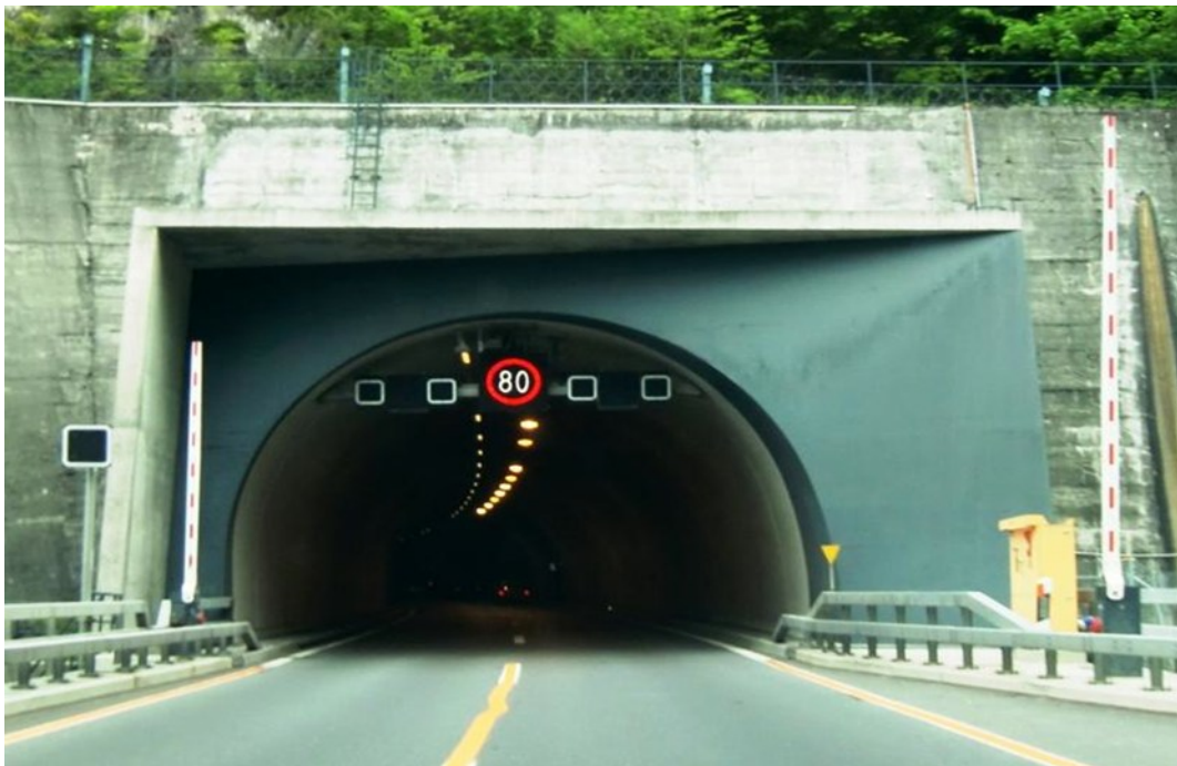
Fig. 12 Barrière au tunnel de Glion.
