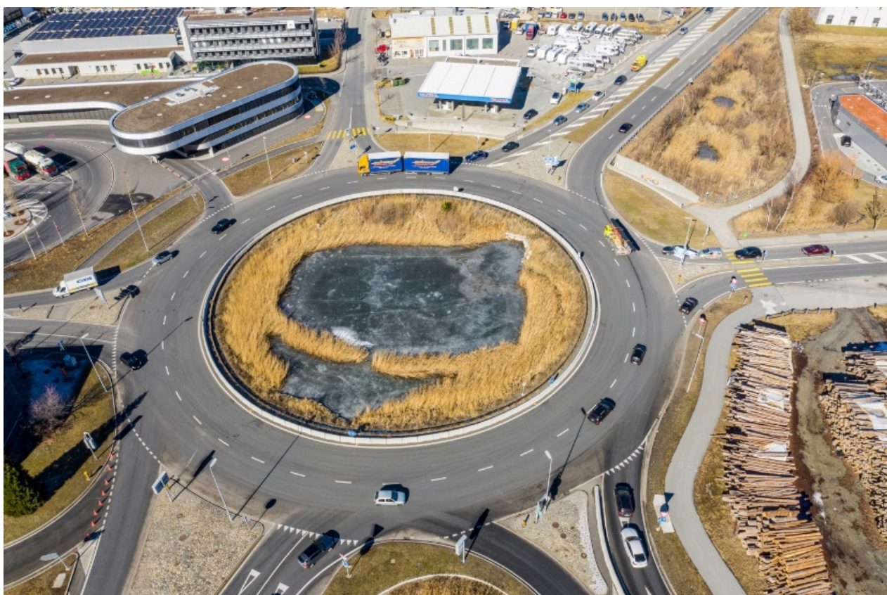
Photo 3 : Système d'évacuation et de traitement des eaux de chaussée au milieu du giratoire de Bildacker, Brigue (VS)
