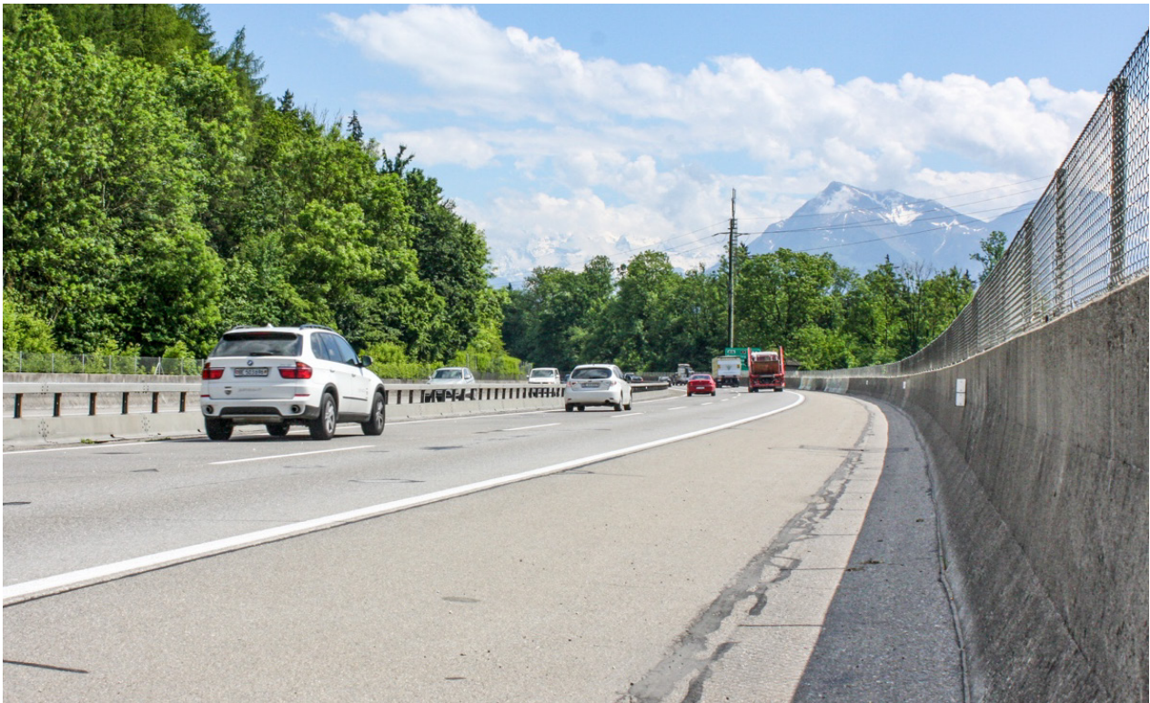
Photo 4 : Bordure sur la A6 près de Kiesen
