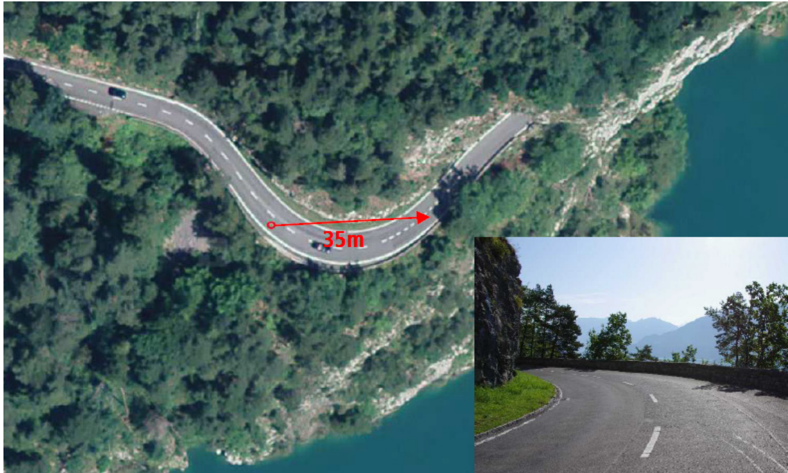
Fig. 46: Distance de visibilité d'arrêt insuffisante
