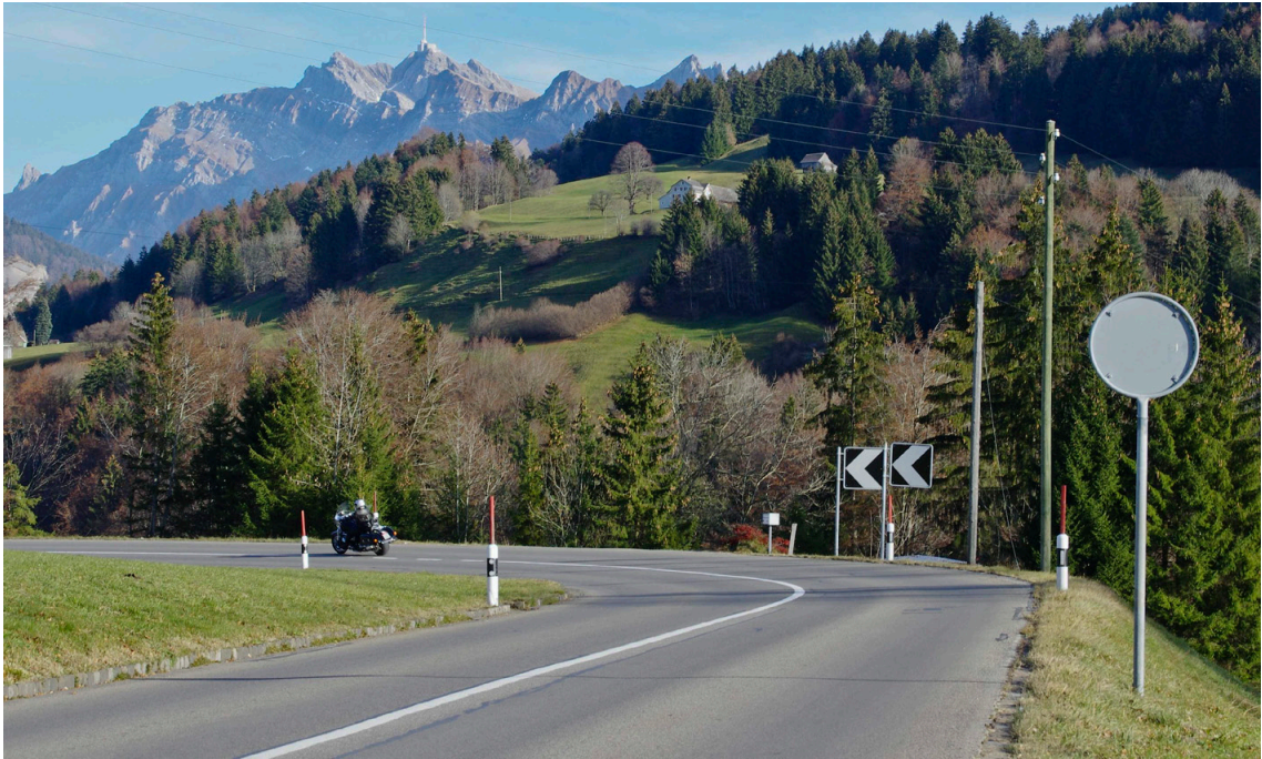
Fig. 81: Signaux et mâts en bois situés à l'extérieur du virage
