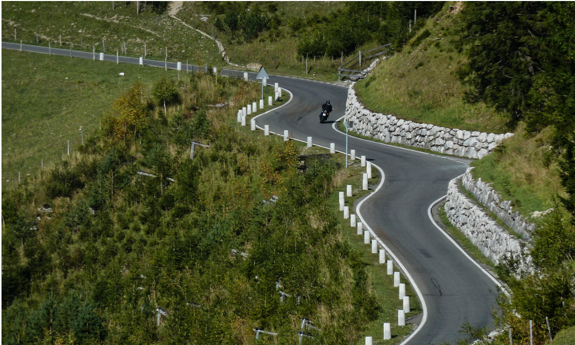
Fig. 83: Blocs rocheux contre les risques de chutes en aval
