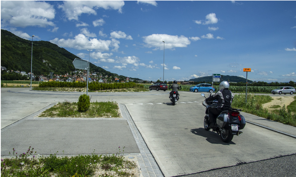
Fig. 75: Chaussée, entrées et sorties d'un rond-point réalisées en béton
