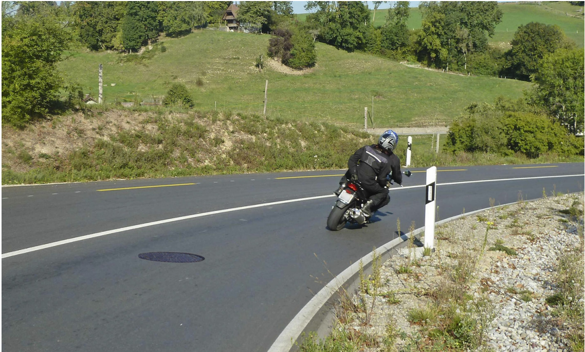
Fig. 77: Couvercle de bouche d'égout situé sur la trajectoire d'un motocycle
