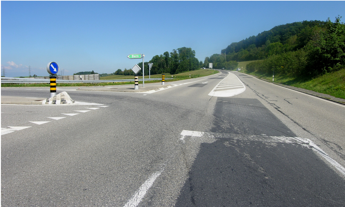
Fig. 67: Marquage abîmé à l'extérieur d'une localité
