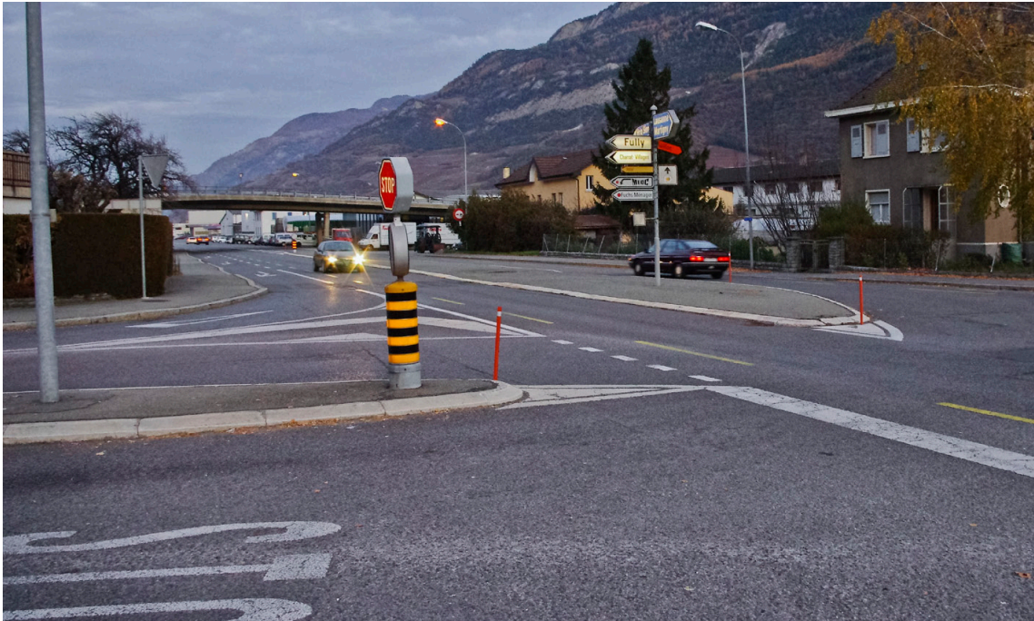
Fig. 30: Manque de visibilité à gauche dû à un signal routier (signaux installés sur le poteau de l'îlot de protection)
