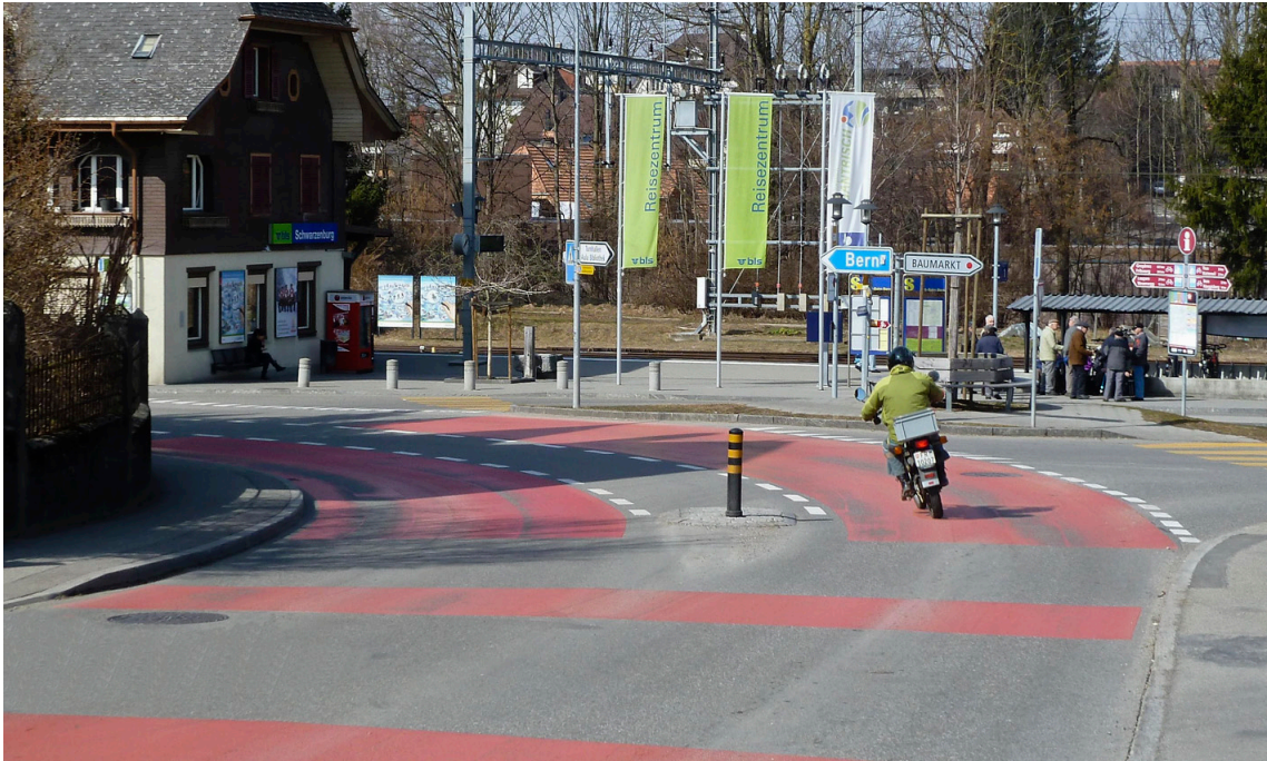
Fig. 38: Aménagement de surfaces routières colorées (ASRC) dans les virages
