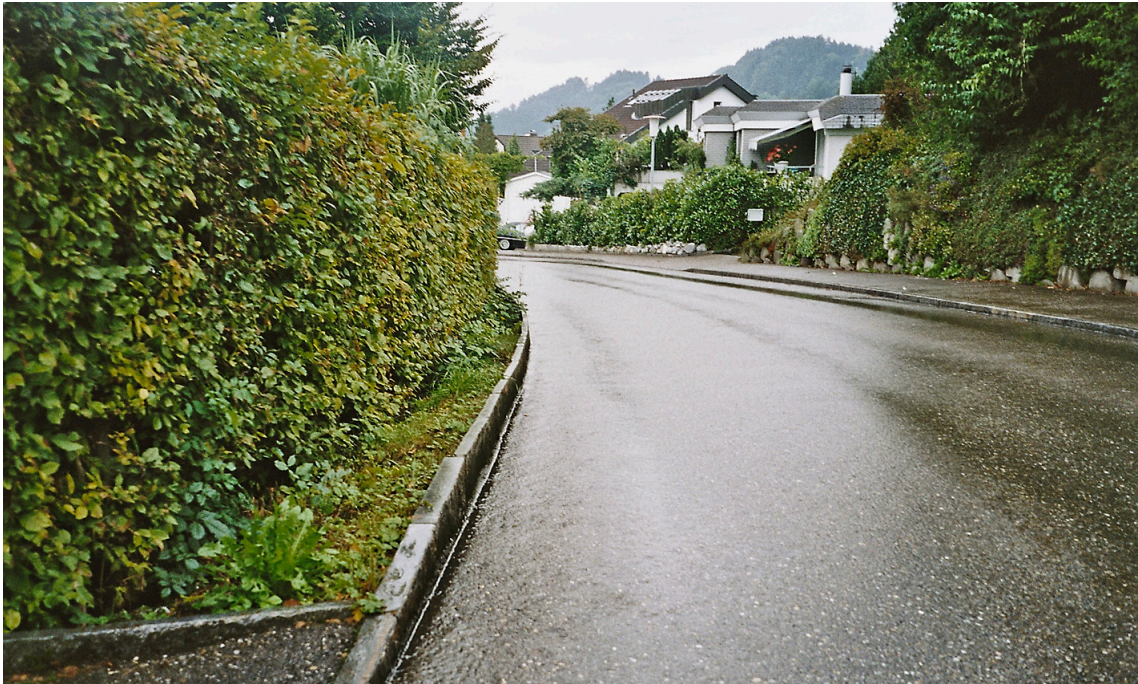
Fig. 26: Diminution de la visibilité due à des plantations
