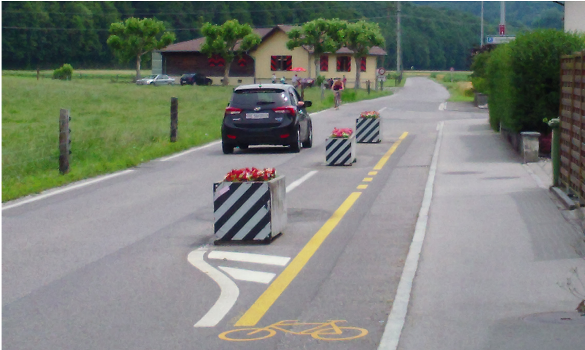
Fig. 44: Exemple difficile à comprendre de mesure de ralentissement de la vitesse à l'intérieur d'une localité
