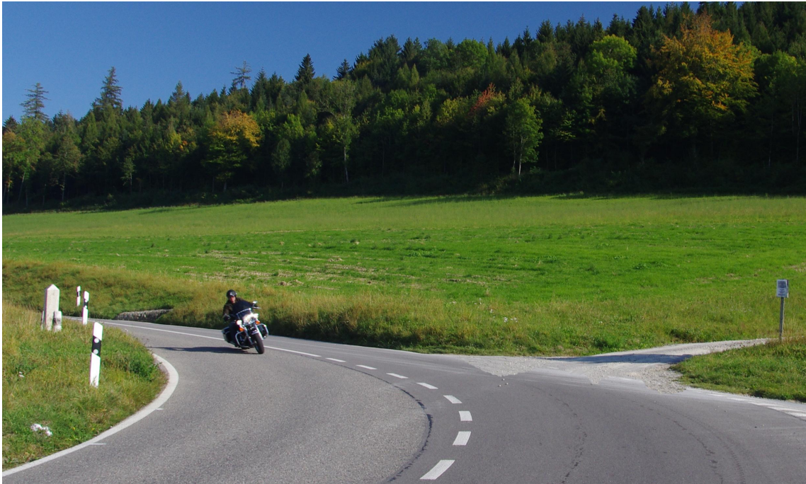
Fig. 69: Dépôt de pierraille sur la chaussée (chemin rural insuffisamment stabilisé)
