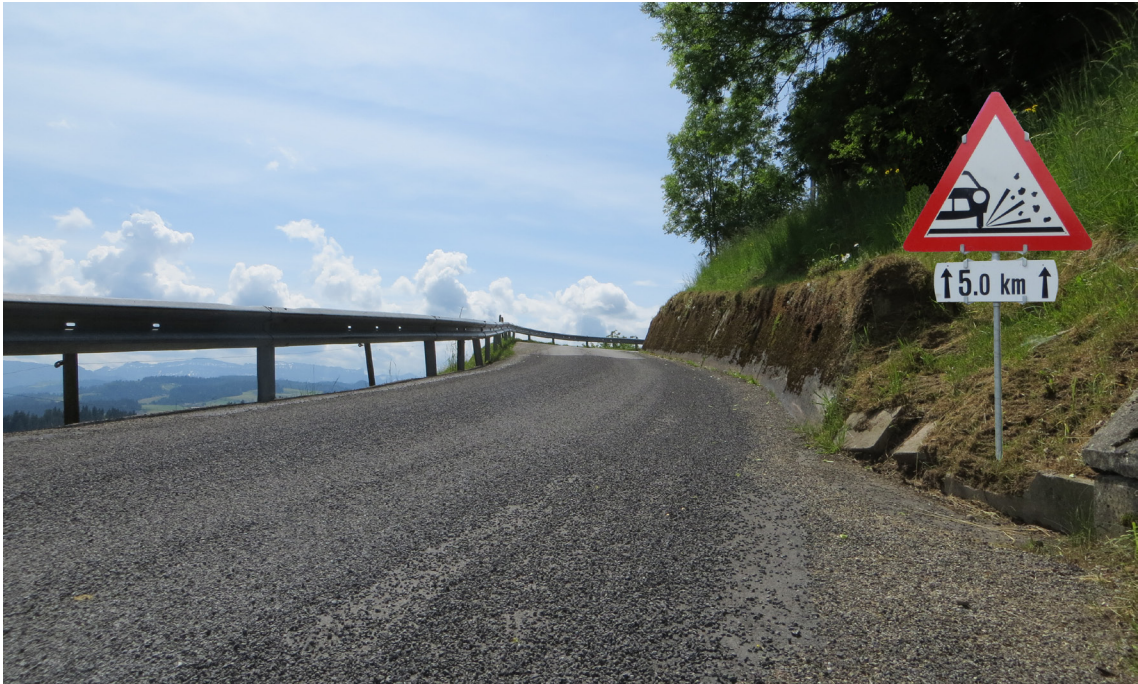
Fig. 73: Renforcement des qualités antidérapantes par l'apport de gravillons
