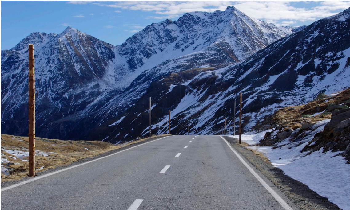
Fig. 50: Tracé difficilement perceptible derrière le dos-d'âne
