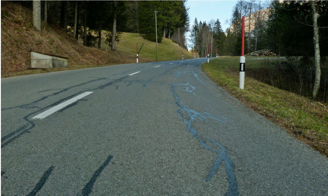
Fig. 60: Réparations de fissures dans la chaussée avec du bitume
