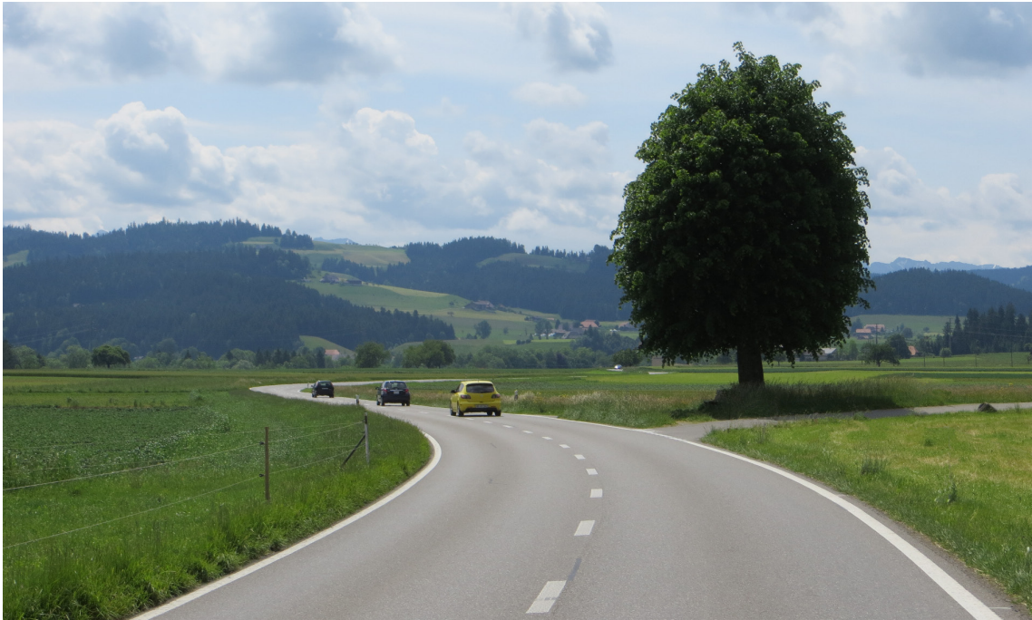
Fig. 79: Arbre isolé dans un endroit de chute potentiel pour un motocycle (extérieur d'un virage)
