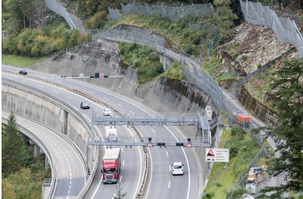
Réseaux de sécurité et de protection sur l'A2 entre Amsteg et Göschenen.
