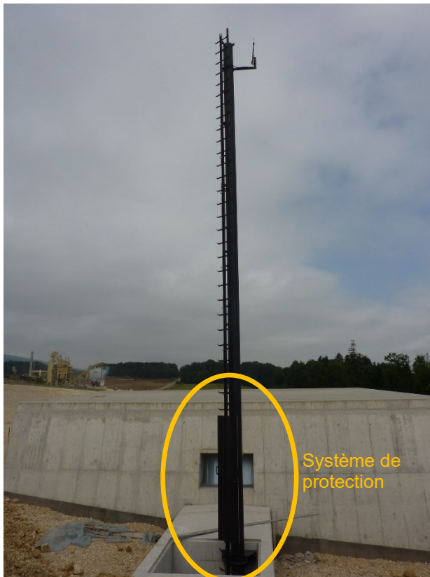
Figure 3.2 : Mât d'antenne avec système de protection
