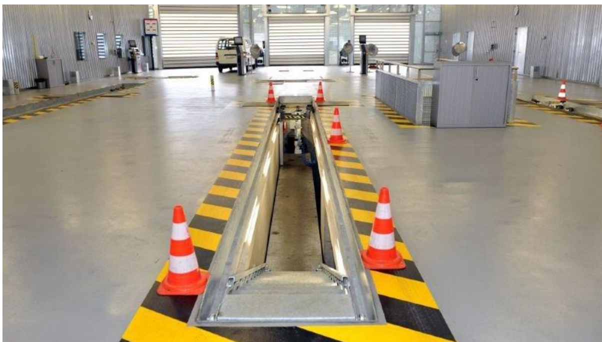
Fosse pour le contrôle de véhicules à Saint-Maurice
