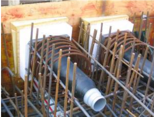
Fig. II.5 Ancrages fixés au coffrage.
