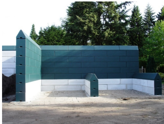
Mur coupe-feu sur place de stationnement, Image: MEGABLOC
