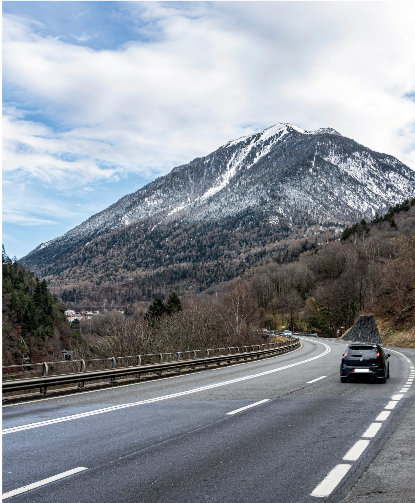
Tronçon N21 Martigny - Grand-St-Bernard, près de Martigny
