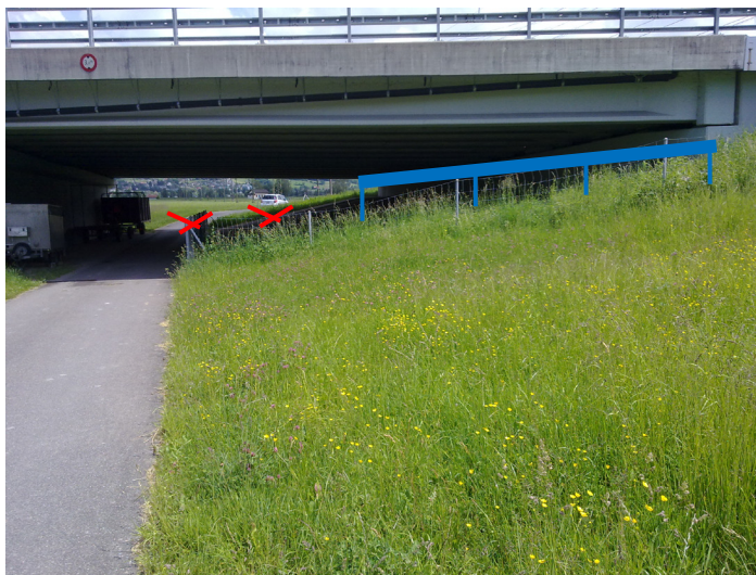
Fig. 3.1 Avec un tracé de clôture adapté (en bleu) et un espace non revêtu le long de la route à proximité de la culée (en rouge la clôture actuelle à supprimer), il serait possible d'améliorer ici la perméabilité pour certaines espèces animales (A53 près de Tuggen / photo: A. Righetti).
