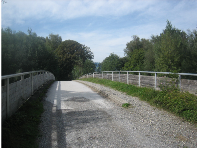
Fig. 2.2 Ouvrage avec trottoir végétalisé (passage supérieur sur l'A13 de Fohlenhof / photo: M. Trocmé).
