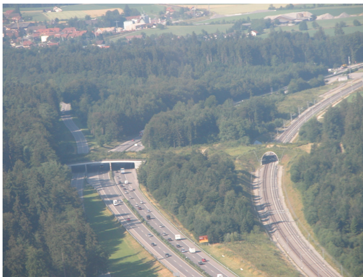
Fig. 2.3 Passage à faune supérieur conforme aux instructions et à la norme concernées à Birchwald (A1), sur un corridor à faune d'importance suprarégionale: à gauche, passage de 50 mètres par-dessus l'autoroute; à droite, passage de 25 mètres par-dessus le nouveau tronçon à deux voies des CFF (photo: Amrein).
