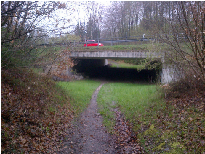
Fig. 2.4 Passage à faune inférieur près de Châtillon (A1) (Foto: Righetti).
