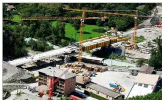
Figure 3: Protection contre l'affouillement (A9 contournement autoroutier de Viège)
