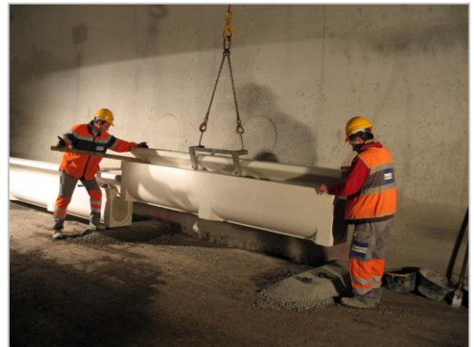
Figure 5: a) Exemple d'un caniveau fendu b) Foto d'un caniveau fendu c) Pose d'un caniveau fendu
