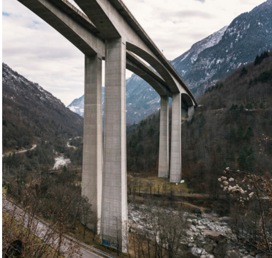
Le viaduc de Biaschina, sur l'autoroute A2 près de Giornico (Léventine, canton du Tessin), est le deuxième pont le plus élevé de Suisse, avec 110 mètres de haut.
