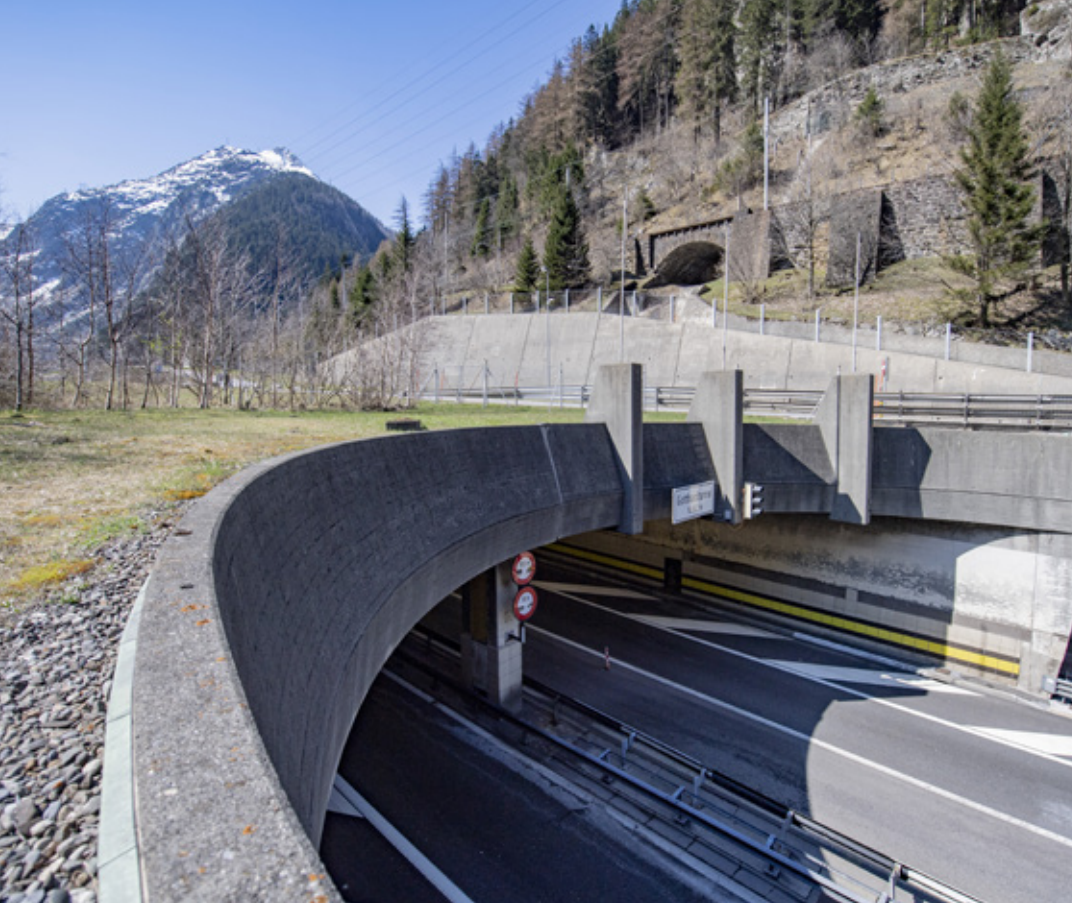
Le portail nord du tunnel du Gothard, sur l'A2 près de Göschenen (vue orientée vers le sud).
