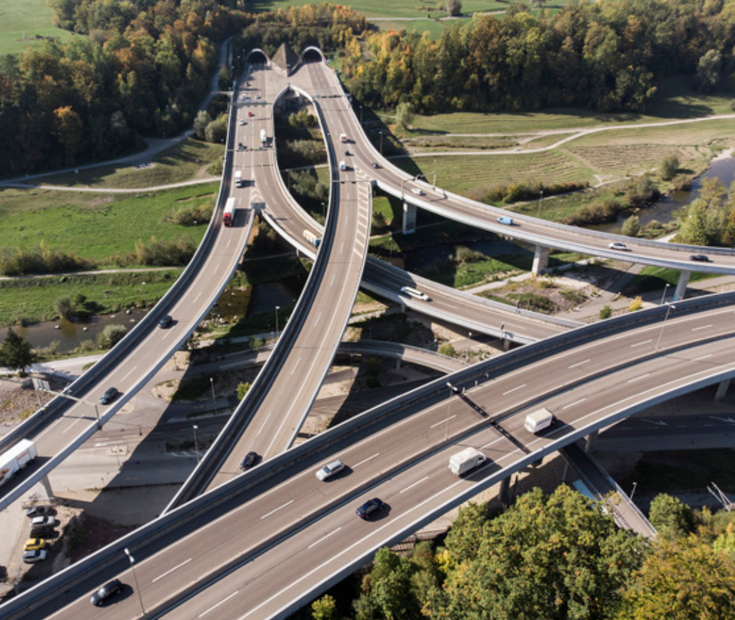
Triangle autoroutier de Zurich ouest et portail du tunnel d'Uetliberg. Prise de vue par drone, le 10 octobre 2018.
