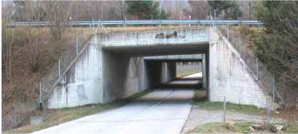
Fig. 5.3 Lors de l'évaluation de la 1 ère phase les ponts-cadres monolithiques encastrés dans le sol sont classés comme suffisamment sûrs du point de vue parasismique [30].
