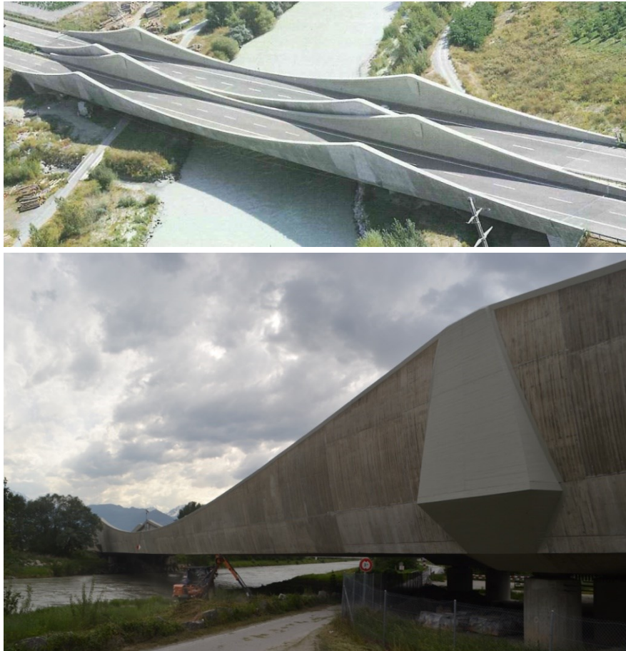
Fig. 10.13 Pont sur le Rhône à Riddes. Vue d'en haut et vue latérale.
