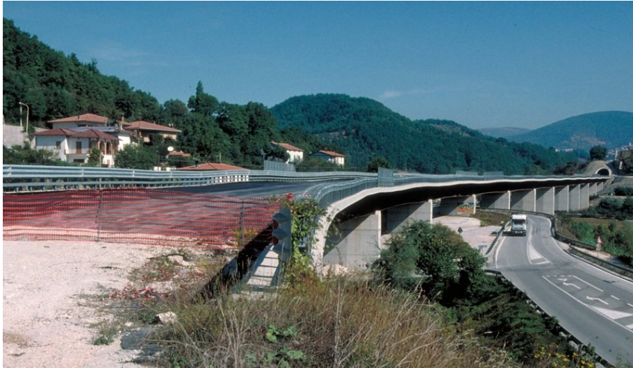
Fig. 3.9 Pont-poutre avec une structure porteuse continue de 657 m de long et appui longitudinal fixe sur la culée, à gauche sur l'image (voir détail Fig. 3.10) [30].
