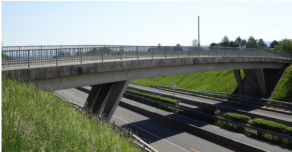
Fig. 5.4 Lors de l'évaluation de la 1 ère phase les ponts monolithiques à béquilles encastrés dans le sol sont classés comme suffisamment sûrs du point de vue parasismique.
