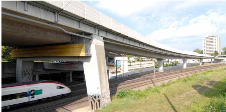
Fig. 10.5 Vue du Singerbrücke D avec l'appui longitudinal fixé à l'origine sur la culée, visible à l'arrière-plan à droite sur la photo.
