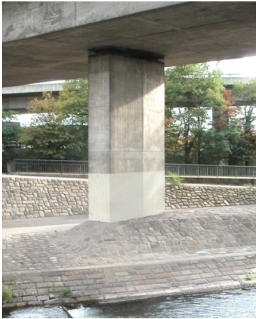
Fig. 4.5 Capacité de déformation horizontale d'une pile fortement réduite par le pavage massif du bord d'un cours d'eau [30].
