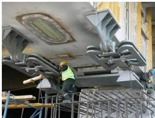
Fig. 9.13 Amortisseurs élasto-plastiques [108]. A droite : loi de comportement et réponse hystérétique.
