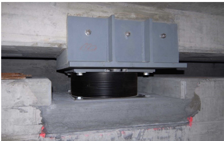
Fig. 10.11 Nouvel appui en élastomère à amortissement élevé, pour remplacer un appui à pot fixe, sur l'appui côté Bex.
