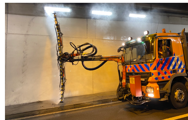
Nettoyage de tunnels
