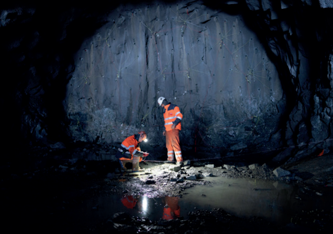
Des mineurs préparent à Göschenen les charges explosives destinées à la construction de la galerie d'accès au deuxième tube du tunnel routier du Gothard.
