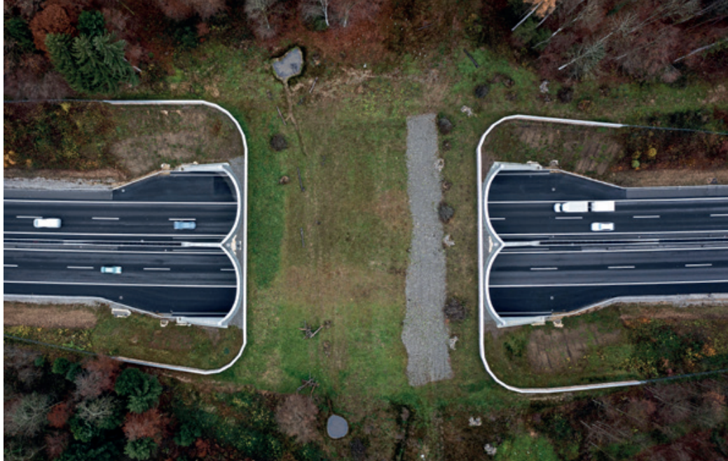
Passage à faune en bois sur l'A1 entre Suhr et Gränichen.
