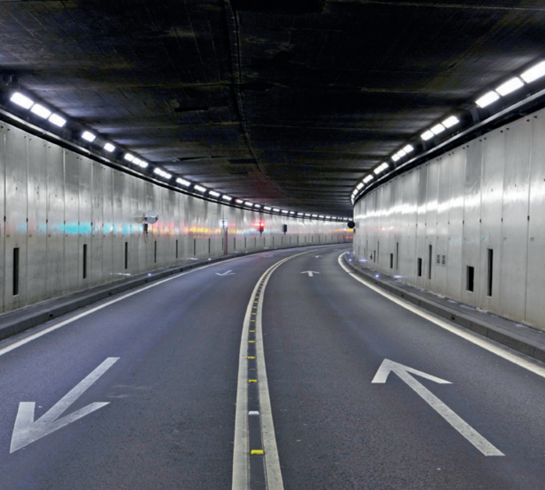
A2, flèches de direction au portail sud du tunnel routier du Gothard.
