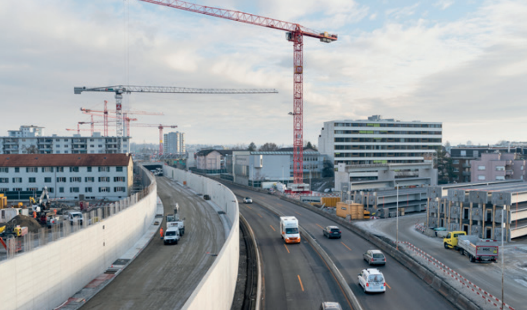
Travaux de construction de la tranchée couverte de Schwamendingen sur l'A1, entre Aubrugg et le tunnel de Schöneich.
