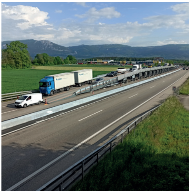
Une approche innovante de l'entretien : l'ASTRA Bridge en utilisation pilote pour des travaux de remplacement de revêtement sur le tronçon de l'A1 Rechterswil-Luterbach.
