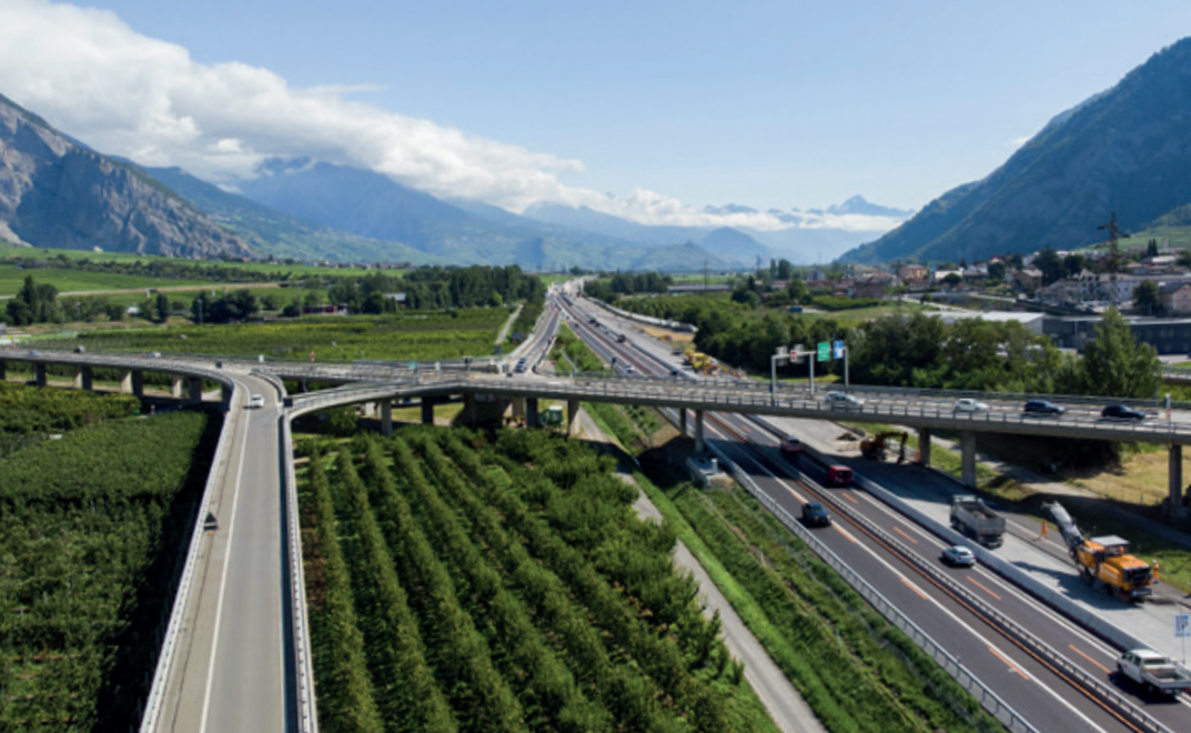
Le Viaduc de Riddes est la propriété commune du canton du Valais et de la Confédération. L'ouvrage, qui enjambe l'A9, a été renforcé en 2021 et il est de nouveau ouvert au trafic.
