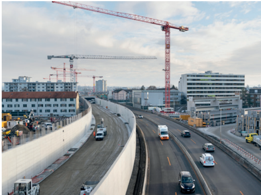
Tranchée couverte de Schwamendingen.
