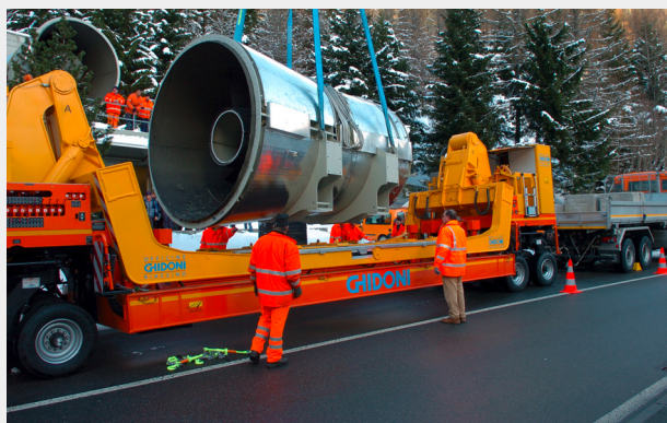
Maintenance des ventilateurs
