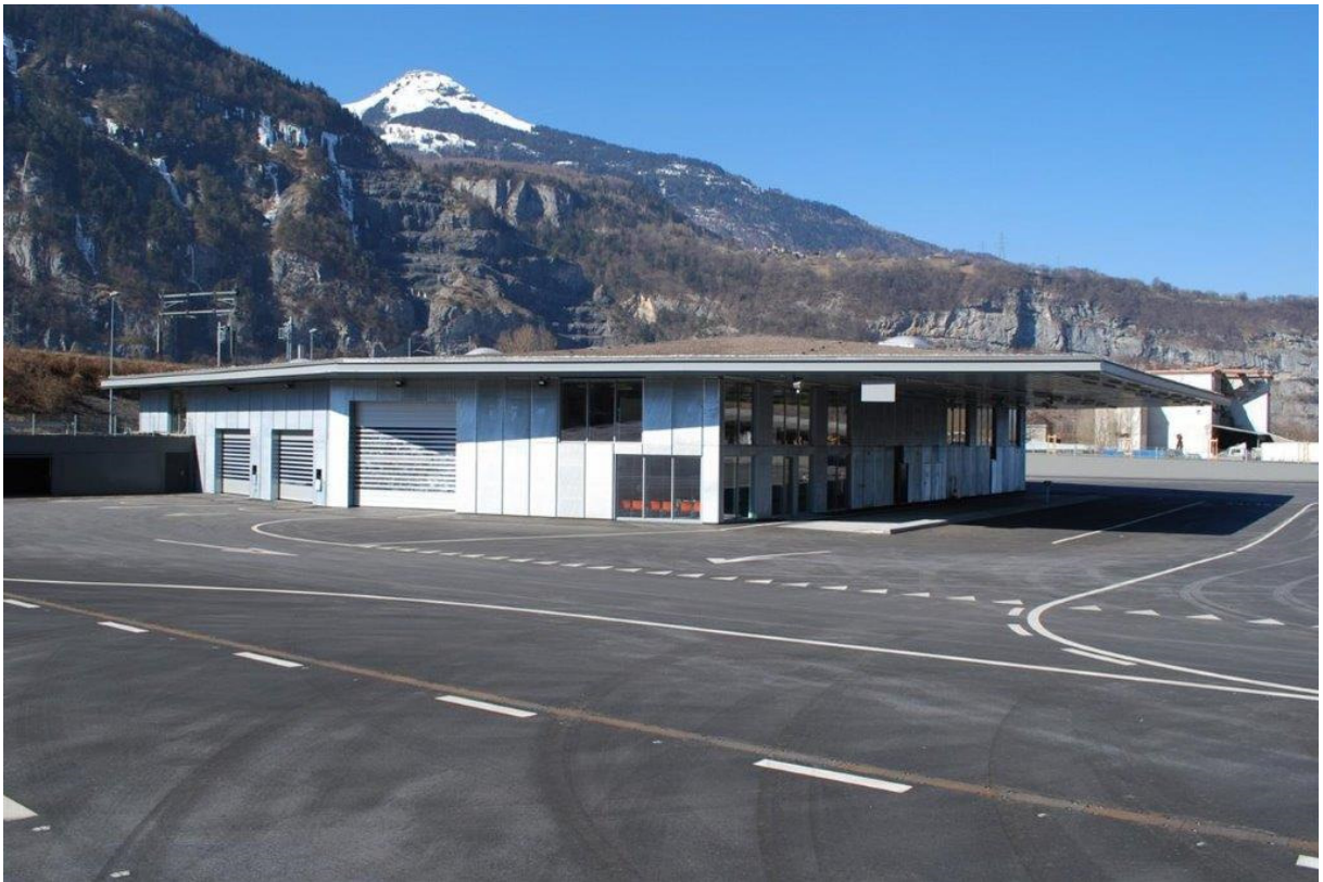
Centro di controllo traffico pesante di Saint Maurice
